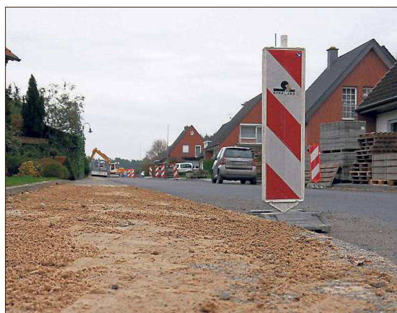
Pünktlich 7 Uhr morgens werden die Bewohner des Alten Münsterwegs in Müssingen von Baulärm geweckt. Die gute Nachricht: Die Arbeiten schreiten zügig voran. Nachdem es anfangs zeitliche Verzögerungen gegeben hatte, ist die Kanalerneuerung nun inzwischen abgeschlossen. Wenn das Wetter mitspielt, sollte die Tragschicht für die künftige neue Fahrbahn aufgebracht sein. Bild: Ossege-Fischer
